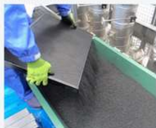
劣化炭抜取り中
