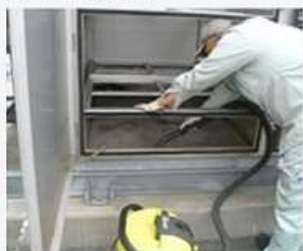
ユニット内清掃中
