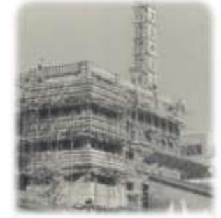
市ヶ谷旧本社ビル建設
